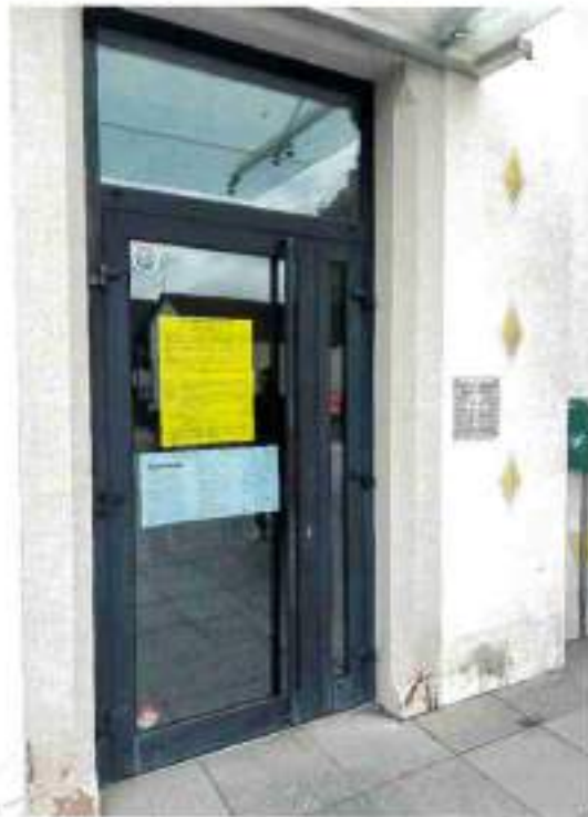
Mairie (accès principal)
