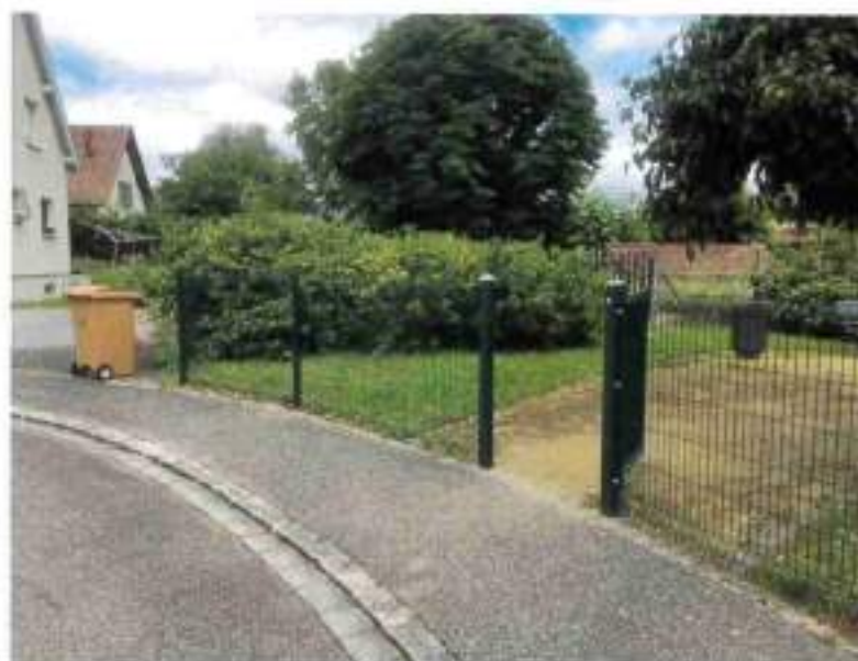
Cliché M.D (Rue des Remparts, au droit parcelle 783)
